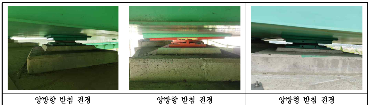
【사진 6.3.15】 교량받침 전경
