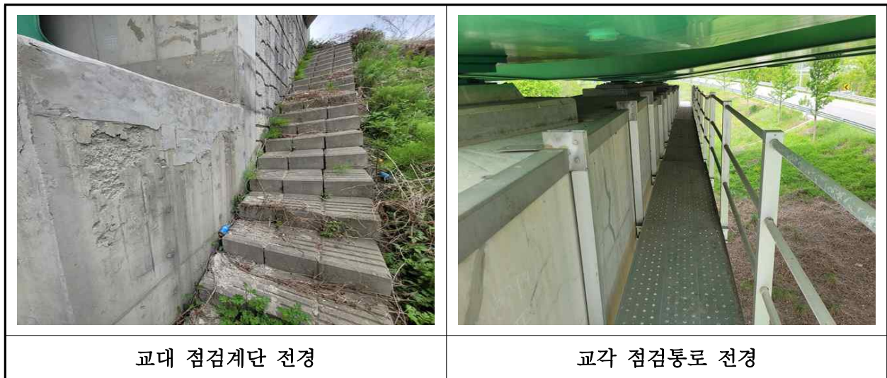
【사진 6.3.28】 교량 점검시설 전경
