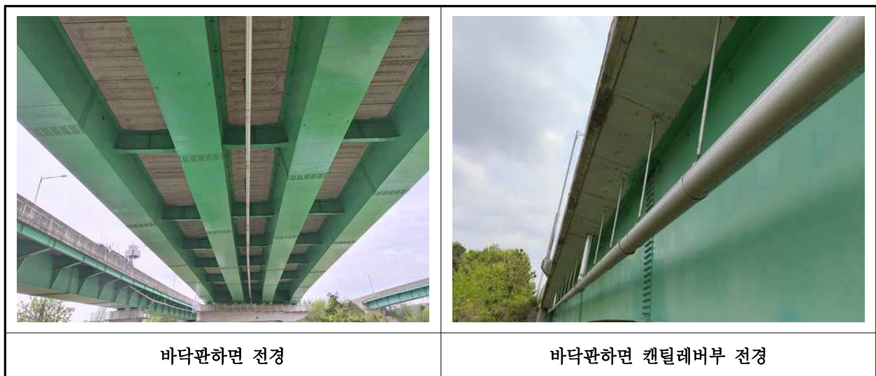
【사진 6.3.2】 바닥판하면 전경
