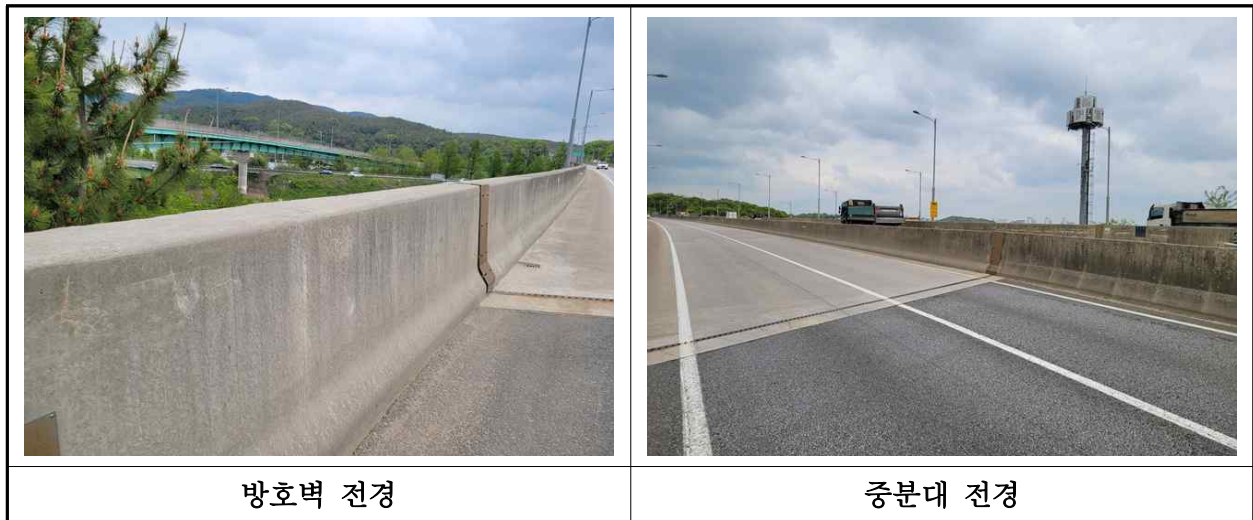
【사진 6.3.26】 방호벽 및 중분대 전경
