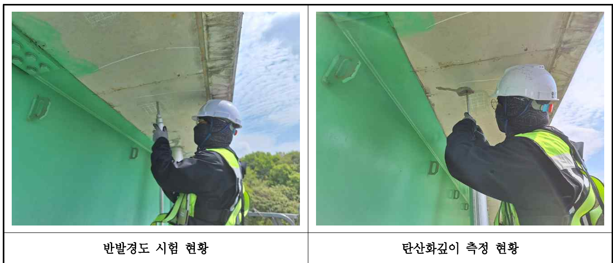
【사진 6.4.1】 콘크리트 내구성조사 현황
