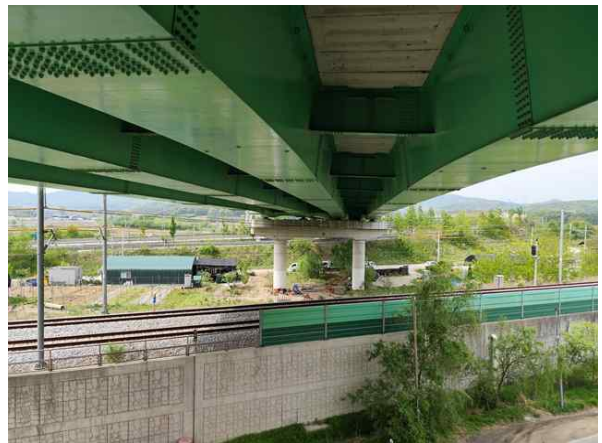
교각 P5 상태현황
