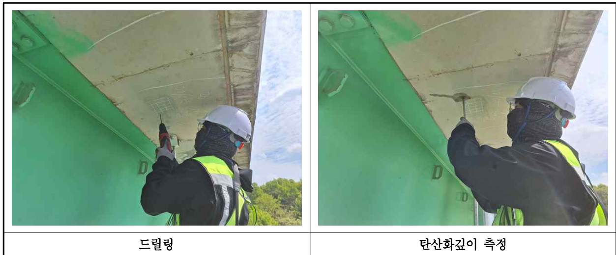
【사진 6.4.3】 탄산화 깊이 측정 현장사진
