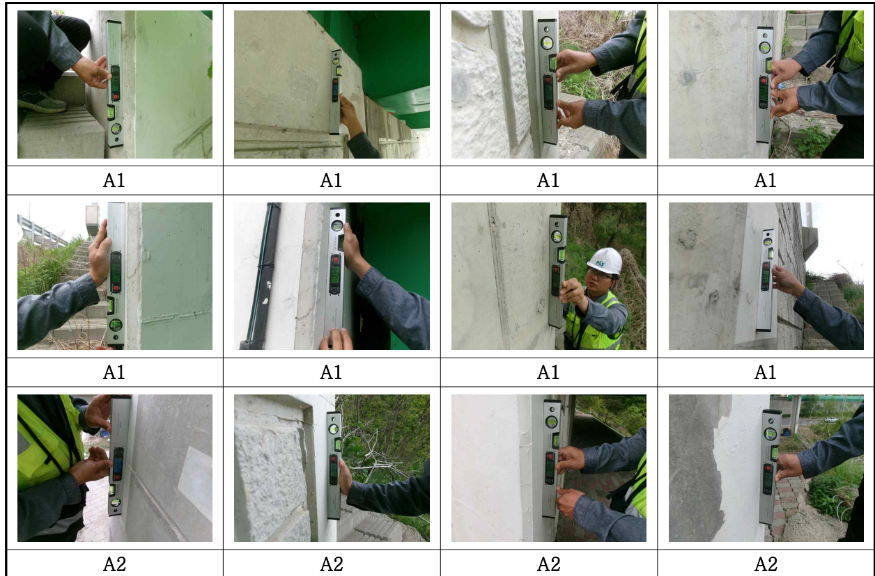
【사진 6.3.10】 교대 기울음 측정 현황
