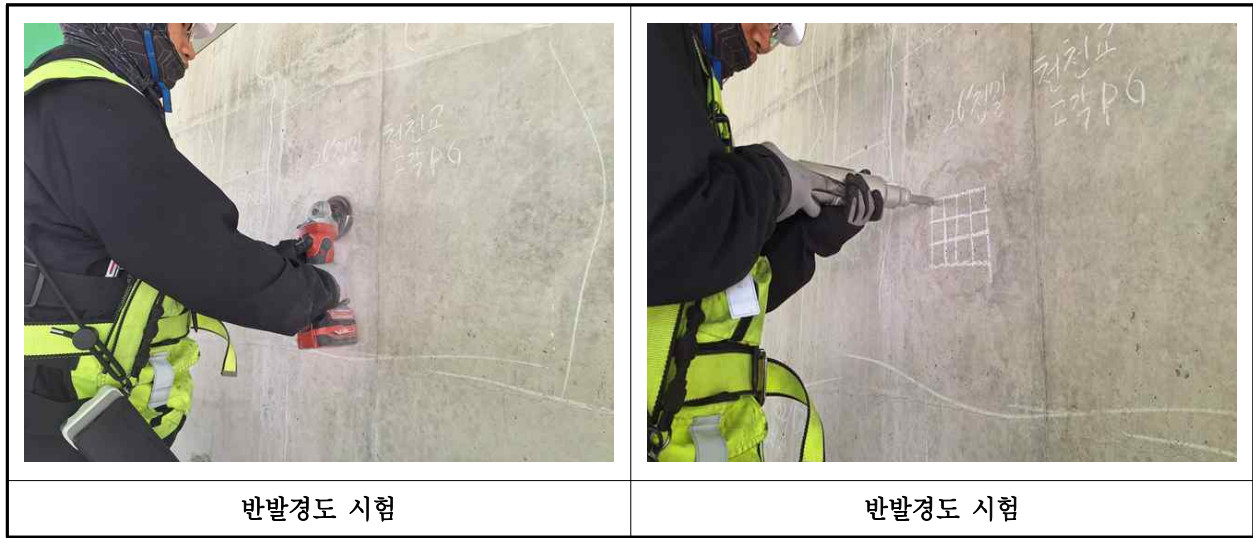
【사진 6.4.2】 반발경도시험 현장사진
