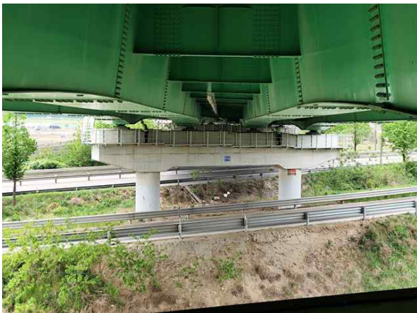
교각 P4 상태현황
