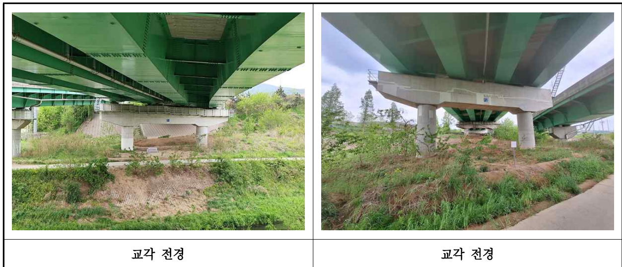
【사진 6.3.11】 교각 전경
