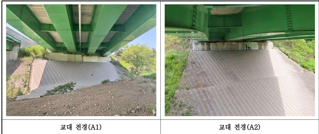
【사진 6.3.8】 교대 전경
