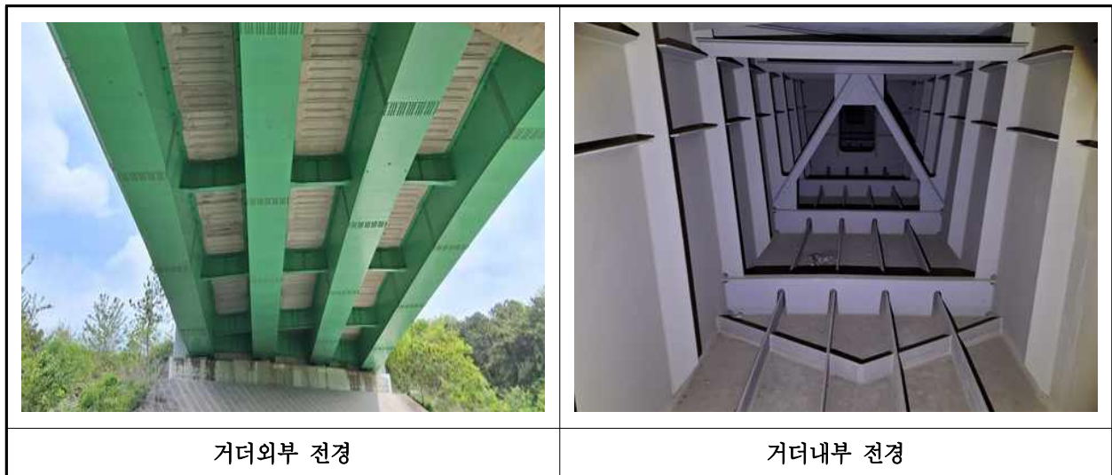
【사진 6.3.4】 거더 전경
