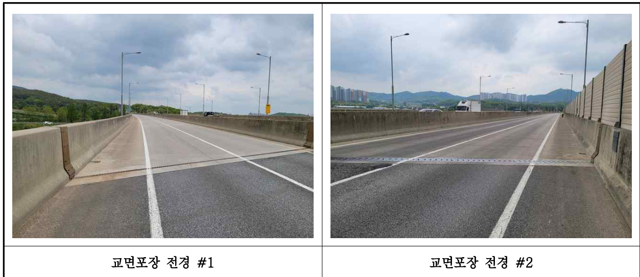
【사진 6.3.22】 교면포장 전경
