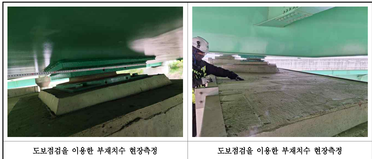
【사진 6.2.3】 부재 현장측정 전경
