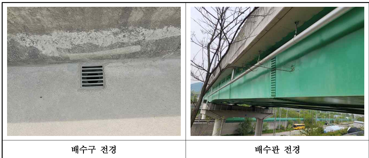
【사진 6.3.24】 배수시설 전경
